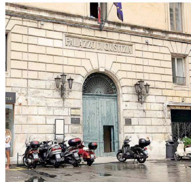
La sede della Commissione tributaria provinciale
